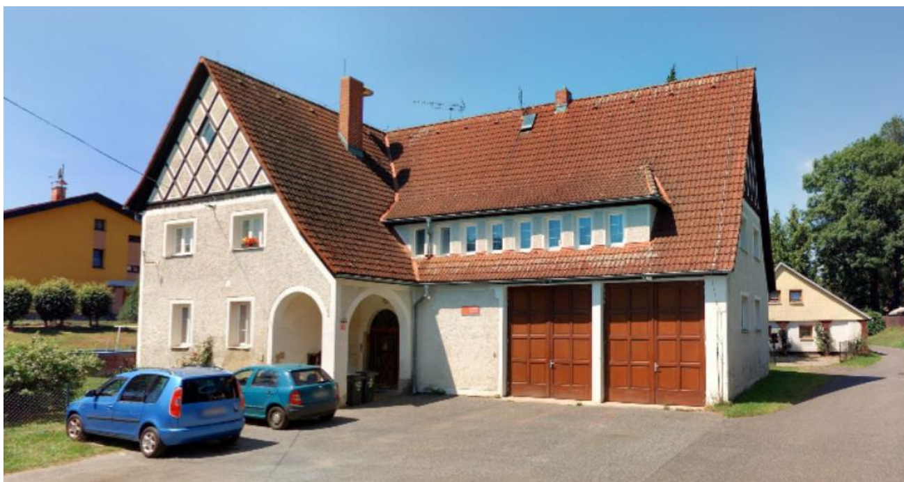
obrázek: hasičská zbrojnice, zdroj: vlastní
