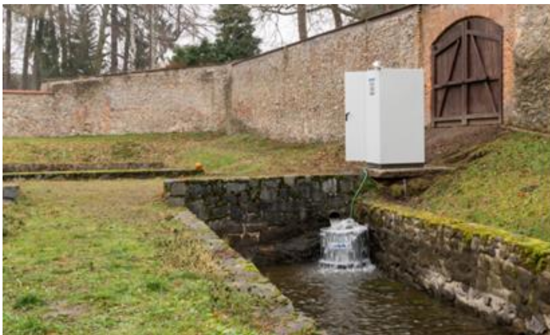
obrázek: příklad umístění vodní mikroturbíny na výpusti, zdroj: ŽĐAS
