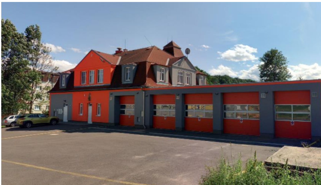
obrázek: hasičská zbrojnice, zdroj: vlastní
