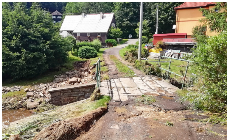
Oprava mostu v ulici Chalupářská.
