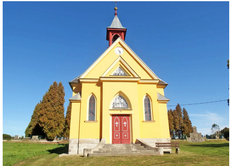
Oprava fasády kaple na Marketě vč. přístupové cesty Čekáme na rozpočet a soutěž, předpoklad 1 000 000 Kč.
