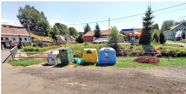
Rekonstrukce sběrných míst Realizace 5/2025, rozpočet 755 535 Kč.
