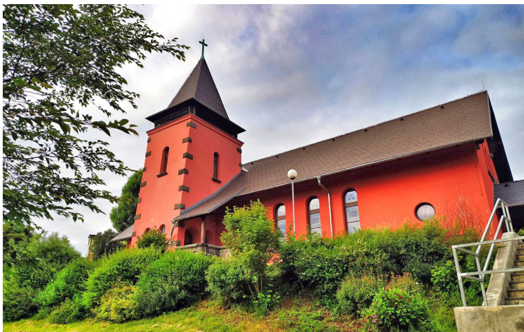
Oprava fasády věže Centra setkávání Čekáme na rozpočet, předpoklad 300 000 Kč.
