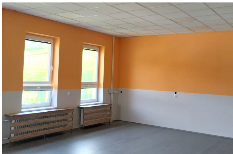
Oprava tříd po realizaci.
