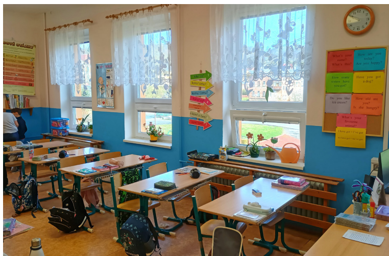
Oprava tříd před realizací.
