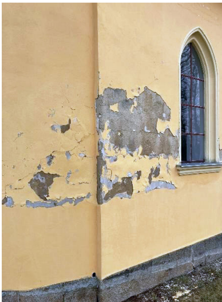
Kaple na Marketě před realizací.
