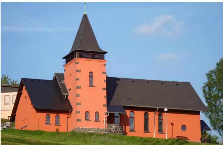
Oprava věže Centra setkávání po realizaci.
