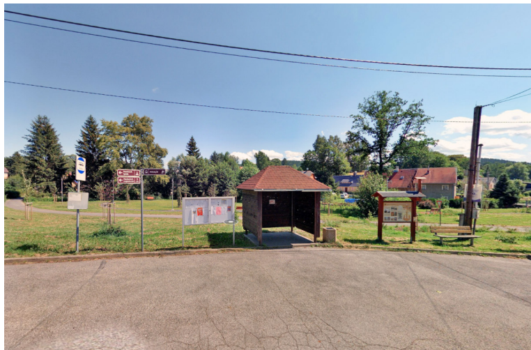
Autobusové zastávky před realizací.
