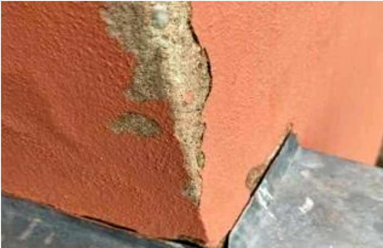
Oprava věže Centra setkávání před realizací.
