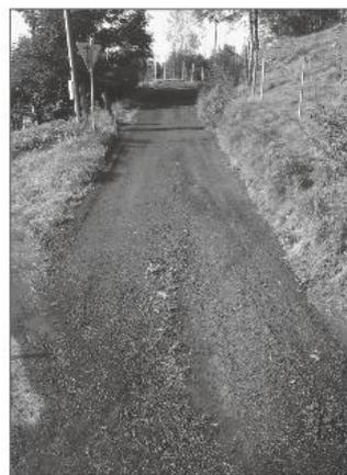
V září byly opraveny některé místní komunikace. Jednalo se o ulici Na Růžku, Akátová, Pod Viaduktem, Příčná a Na Svahu. Opravy prováděla firma KM Nezmar frézovaným recyklátem.
