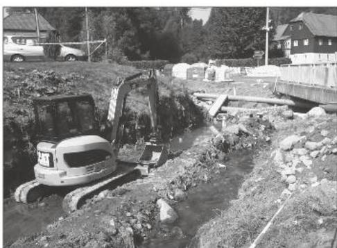
Povodí Ohře začalo v měsíci září s rekonstrukcí břehových zdí na kritických místech Lučního potoka, které poškodila povodeň. Snímek je z Horní Poustevny pod benzinovou pumpou.
