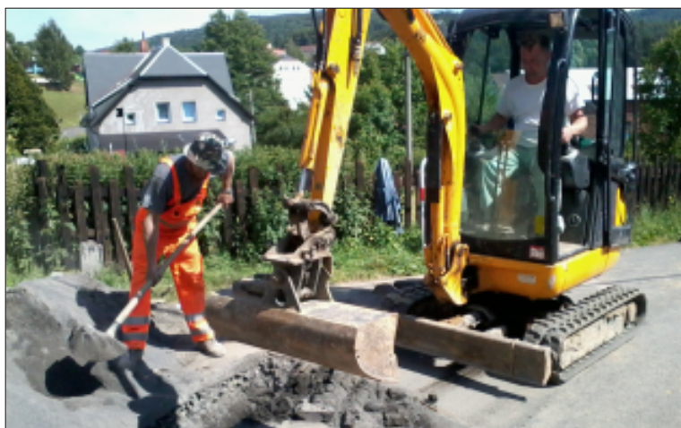
Firma KM Nezmar napojuje kanalizační přípojku v Týršově ulici pro bytovku č.p. 410 - 413.
